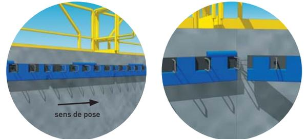
3 Adapter le dernier ensemble en le coupant à la longueur nécessaire. Ôter préalablement les armatures au droit de la coupe et assurer l'étanchéité du boîtier par la pose d'un adhésif.
